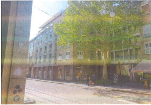
POGLED NA ZGRADU - sa llice
